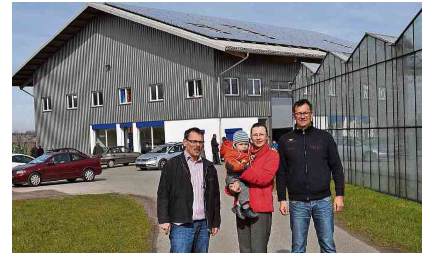
Freuen sich über die neue Photovoltaikanlage auf dem Biohof: Roland Etter, Gemeinderat, Irina Moor, Präsidentin Steinachsolar, und Andreas Andermatt vom Biohof (von links).
